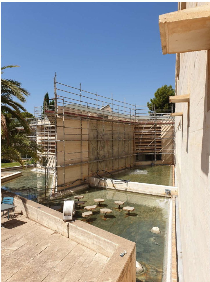
Vista parcial de les obres a l' Edifici Moneo
