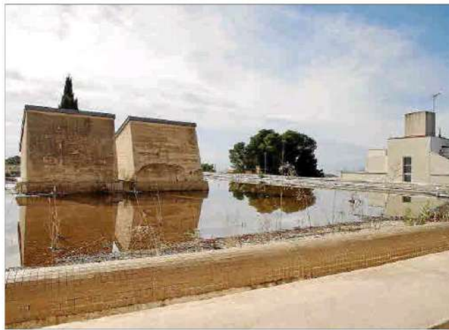
El grueso de la reforma se ejecutará sobre los 800 metros de la cubierta del edificio. Fotos: PILAR PELLICER
