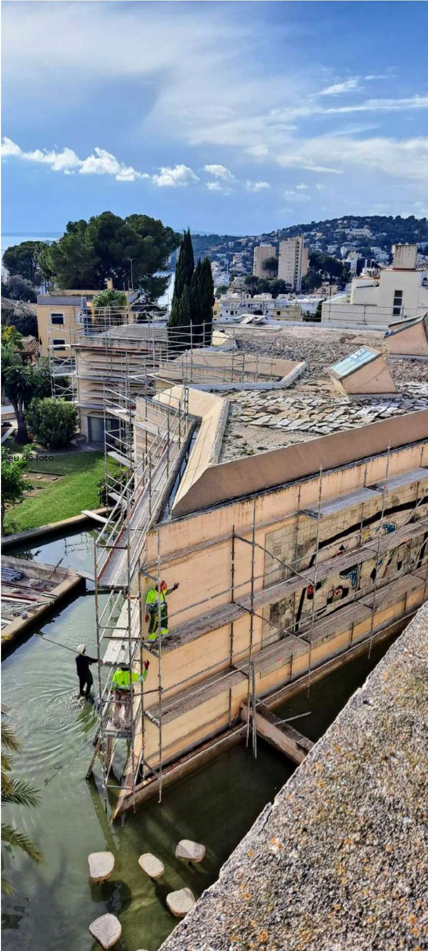
Imatge de les obres a la coberta de l'Edifici Moneo
