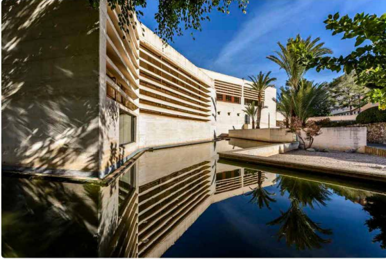
Edificio MoneoRubén Perdomo
