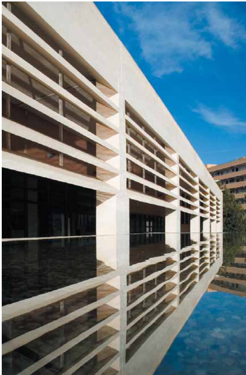
Detall de l'edifici Moneo Fotografia: Diego D'Intino
