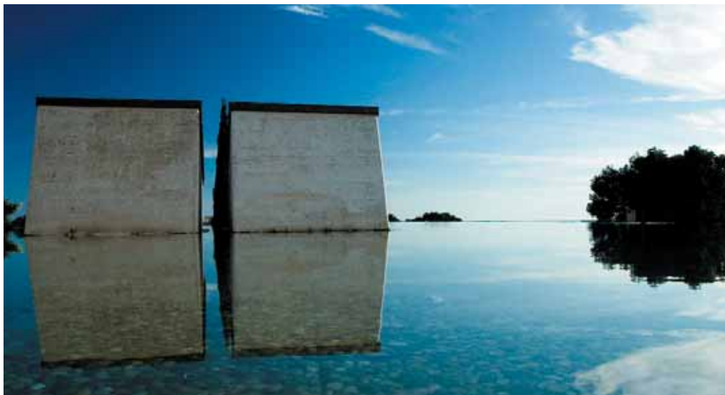
Exterior de l'Edifici Moneo (esquerra), Espai Estrella (a dalt) i estany de l'Edifici Moneo (a baix) Fotografies: Diego D'Intino
